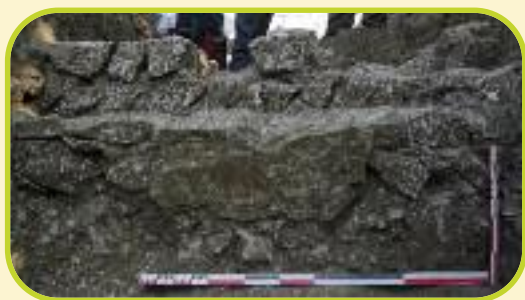
Figure 4 : trace d'enduit de chaux sur la paroi interne du mausolée.
